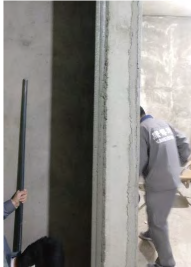
Fig. 12 Actual plastering results
