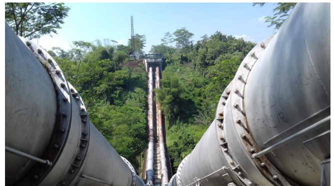
Fig. 4. Syphon site in Kepanjen
