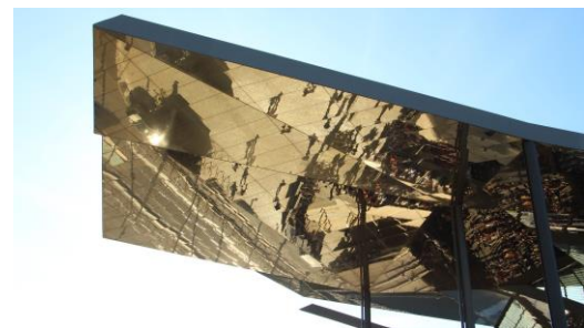
Fig. 4. Market Els Encants in Barcelona. b720 Fermín Vázquez Arquitectos, 2013.
