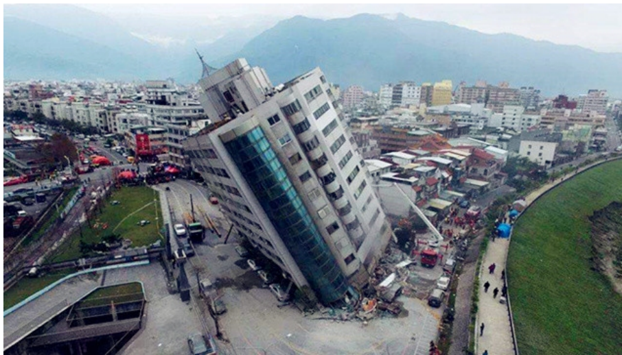
图3 花莲地震主要建筑物倒塌破坏位置(台湾国家实验研究院). (3a)花莲地震主要破坏性建筑物的位置; (3b)云翠大楼破坏倒塌情况。
