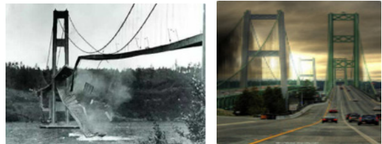
图 1 正在坍塌的大桥
