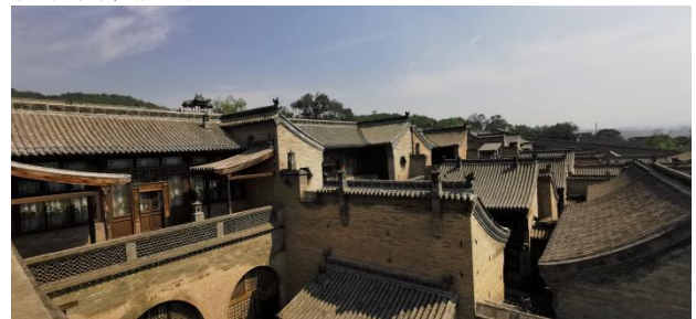
图2 视履堡聚落建筑群外部空间
