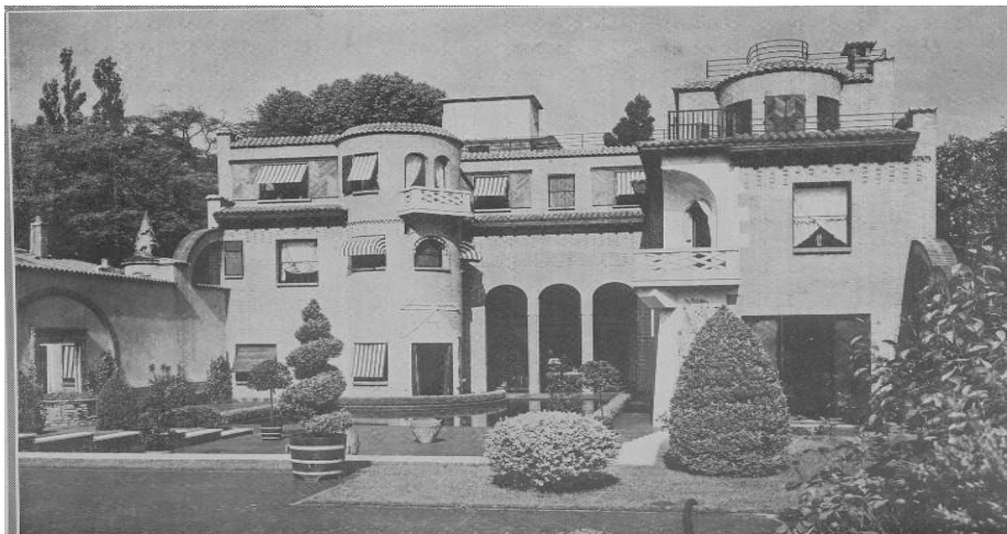
Figure 4 I. Fidler, A. Polyakov, Hôtel Worth, 1930-1932, 83, rue de Longchamps, Neuilly-sur-Seine. From: La construction moderne, revue hebdomadaire d'architecture, n. 21, 19 février 1933.
