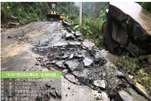
(a) 脚木足乡道路受地震破坏
