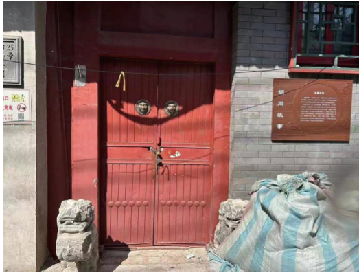
Fig. 3. Anhui Guild Hall(Exterior)
