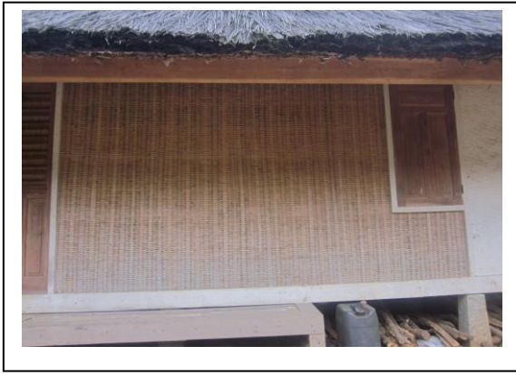
Fig. 5. Wall of Kampung Naga Tradisional House
