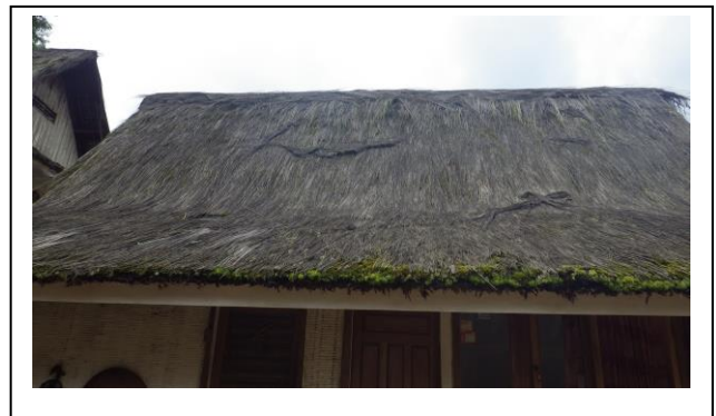
Fig. 4. Roof of Kampung Naga Tradisional House
