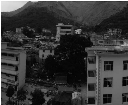
图6 龙头山镇的场地地形及震后倒塌情况(镜头方向:北西)
