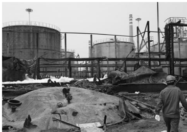
图 1. 中石油大连石化分公司三苯罐区小罐区“6·2”事故现场
